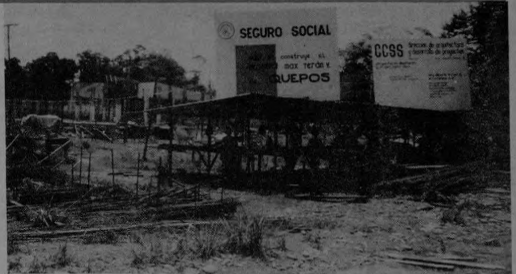
La construcción del hospital Max Terán V., en sus inicios.
